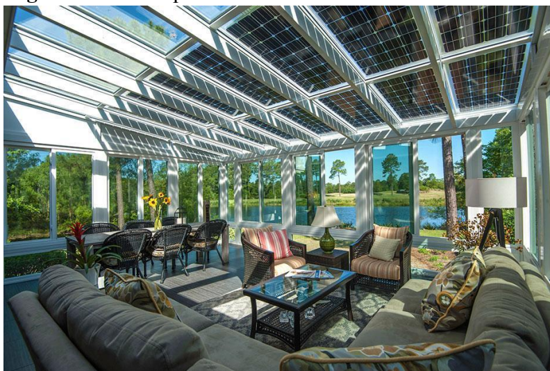
Figura VII: Exemplo de uma varanda com módulos bifaciais
